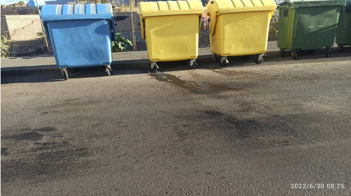
**FALTA:** Derrame de líquidos hidráulico de los camiones del servicio.29/06/2022.
