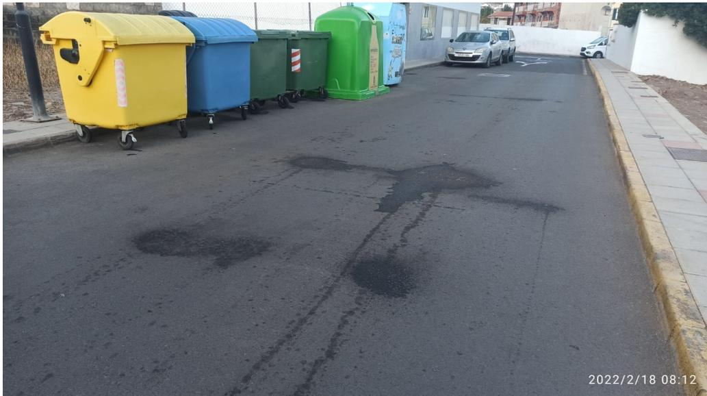
**FALTA:** Derrame de líquidos hidráulico de los camiones del servicio.30/06/2026.
