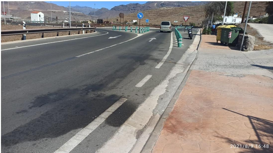
**FALTA:** Derrame de líquidos hidráulico de los camiones del servicio.07/09/2021.
